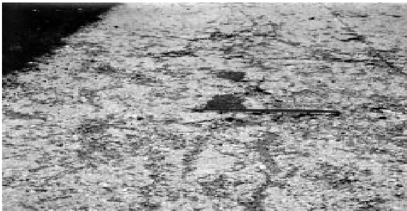
Х2.43-р зураг - Эвдрэлийн түвшин өндөр торлосон холбоост хагарал ба хялгасан хагарал
