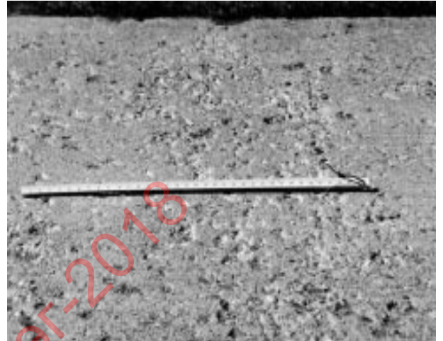
Х2.42-р зураг - Эвдрэлийн түвшин дунд торлосон холбоост хагарал ба хялгасан хагарал
