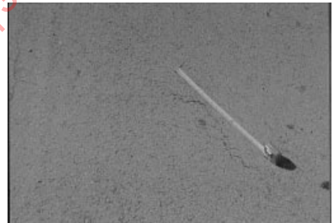
Х1.47-р зураг - Эвдрэлийн явц багатай шилжилтээс үүсэх хагарал
