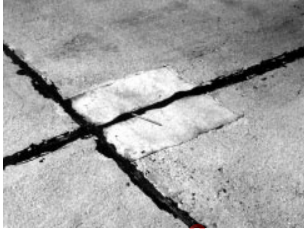
X2.28-р зураг - Эвдрэлийн явц багатай бага хэмжээний нүхэн засвар
