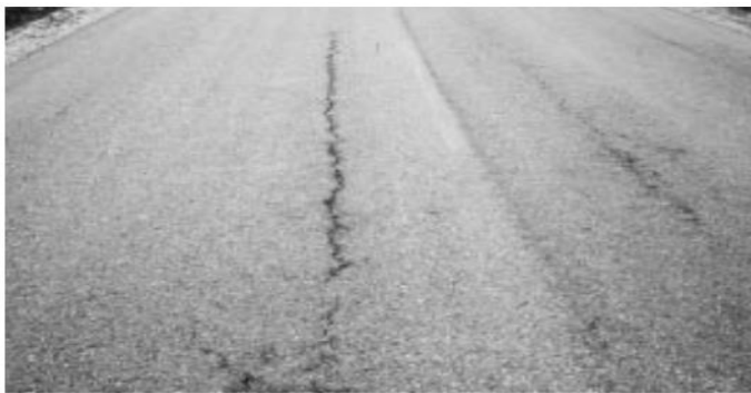
55-р зураг- тээврийн хөдөлгөөний ачааллаар үүссэн дугуйн мөрний дагуух хагарал
