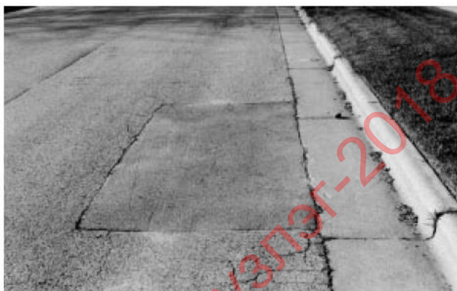
90-р зураг- Ашиглалтын 4 онооны түвшин. Дугуйн мөрний ховил үүссэн нөхөөстэй зам.
