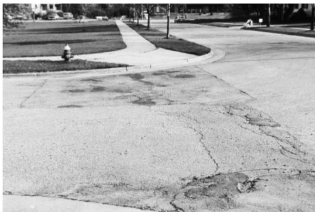
97-р зураг- Ашиглалтын 3 онооны түвшин. Нөхөөс хийсэн хэсэгт дахин эвдрэл үүссэн зам.
