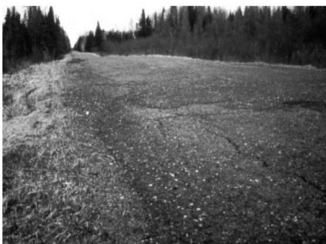
101-р зураг- Ашиглалтын 2 онооны түвшин. Хүйтний овойлтоос эвдэрсэн зам.
