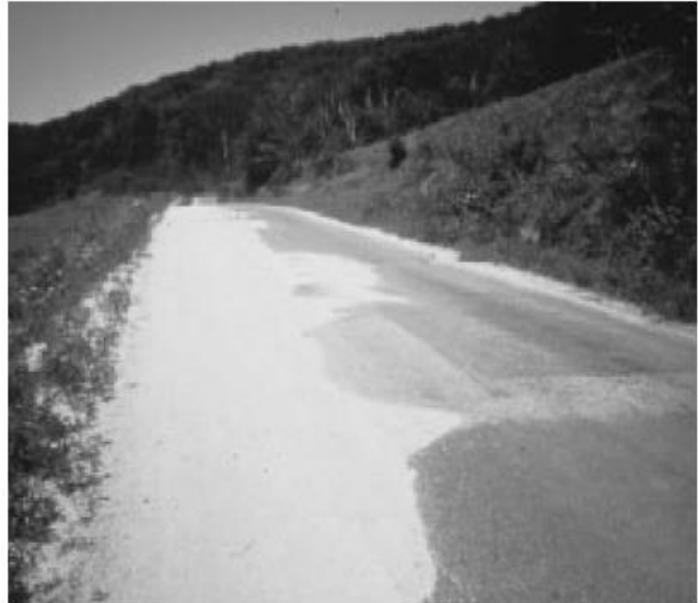
86-р зураг- Ашиглалтын 5 онооны түвшин. Нөхөөс нилээд хийгдсэн ч нөхөөсний орчим эвдрэл хэв гажилт үүсээгүй байгаа зам.
