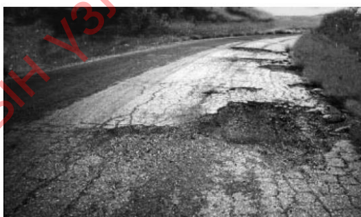
103-р зураг- Ашиглалтын 1 онооны түвшин. Торон хагарал даамжирч нүх үүссэн зам.
