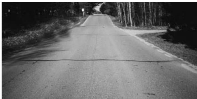
45-р зураг- Харьцангуй хол зайтай үүссэн хөндлөн хагарлыг гагнасан байдал
