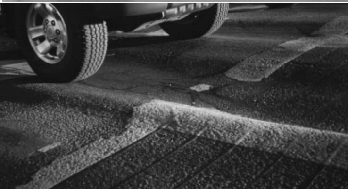
41-р зураг- Хольцны орц найрлага муу тогтоогдсоноос дугуйн мөрний ховилын гүн 5.0 см-ээс их болсон байдал
