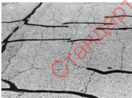
90-р зураг- Ашиглалтын 4 онооны түвшин. Дугуйн мөрний ховил үүссэн нөхөөстэй зам.
