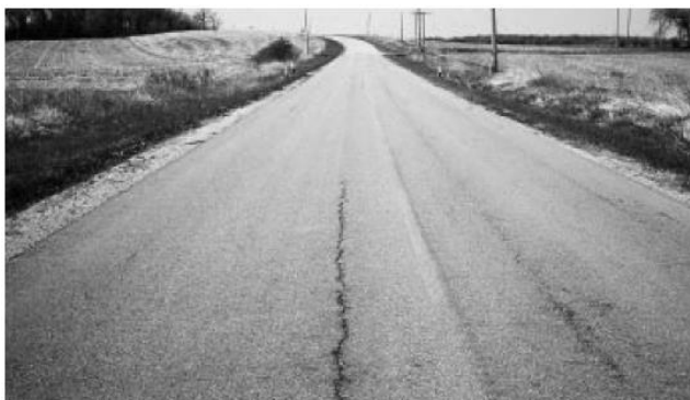
89-р зураг- Ашиглалтын 4 онооны түвшин. Ачааллын үйлчлэлээр дагуу хагарал үүссэн зам.
