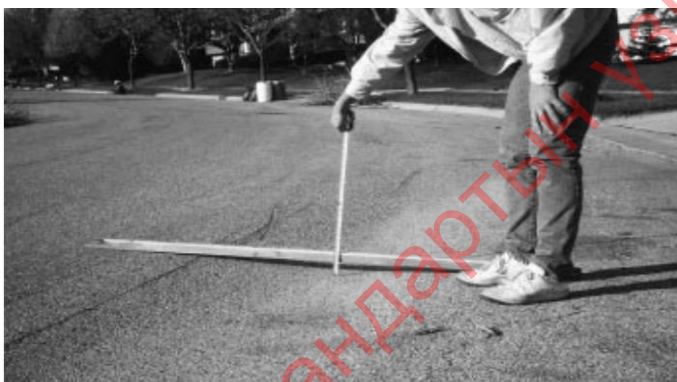
44-р зураг- Хүйтний овойлт явагдсан хэсэг хавар гэсэж жигд бус овойж суусан байдал.
