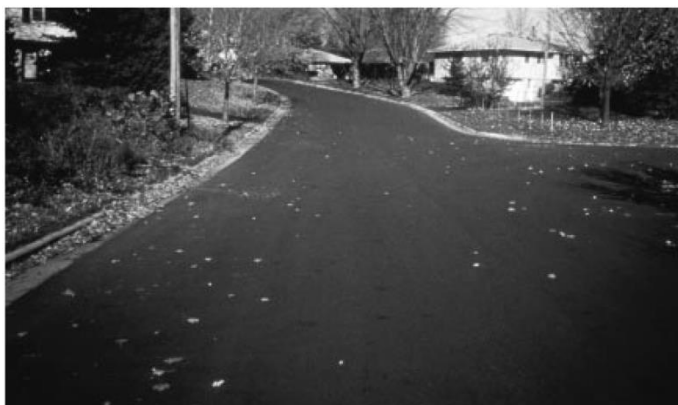
70-р зураг- Ашиглалтын 9 онооны түвшин. Шинээр overlay дэвссэн зам.
