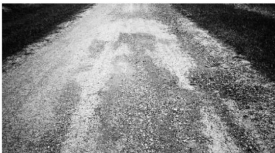
102-р зураг- Ашиглалтын 1 онооны түвшин. Хүйтний овойлтоос эвдэрч нүх гарсан зам.
