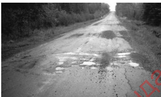
102-р зураг- Ашиглалтын 1 онооны түвшин. Хүйтний овойлтоос эвдэрч нүх гарсан зам.
