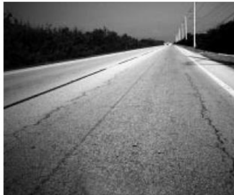
88-р зураг- Ашиглалтын 4 онооны түвшин. Дугуйн мөрний хэсэгт ховил, дагуу хагарал үүссэн зам
