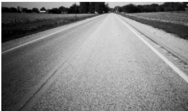
71-р зураг- Ашиглалтын 8 онооны түвшин. Дан гадаргуун боловсруулалт хийсэн хучилт.
