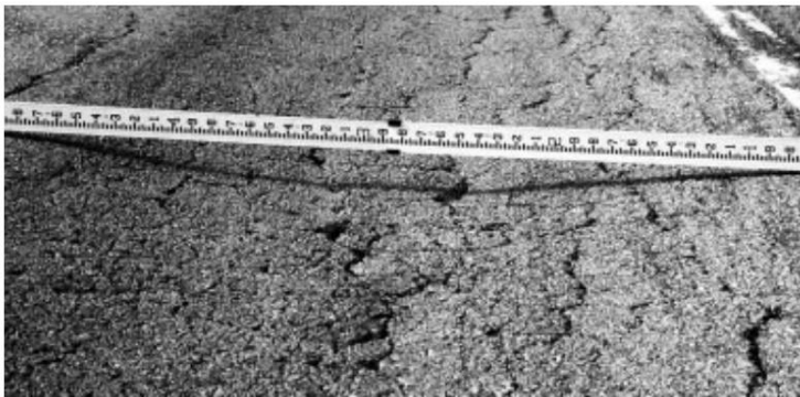
42-р зураг- Хучилтын суурь, дэд суурийн чанар, нягтрал муугаас үүссэн дугуйн мөрний ховил.
