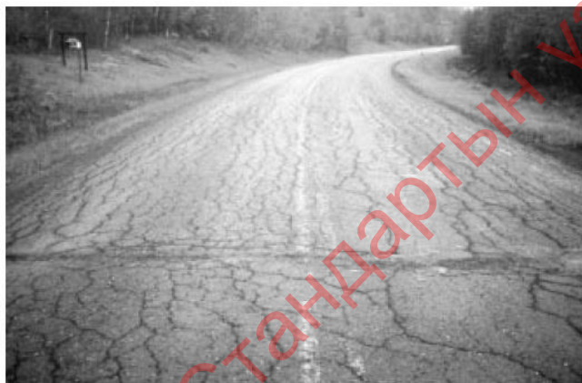
98-р зураг- Ашиглалтын 2 онооны түвшин. Торон хагаралтай, ирмэгийн эвдрэлтэй зам.
