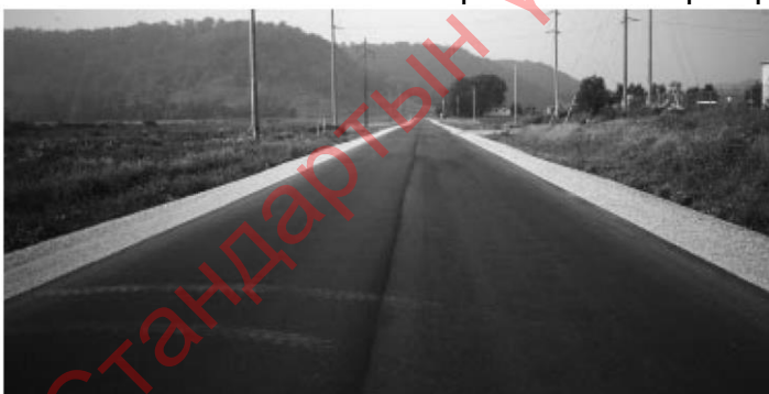
68-р зураг- Ашиглалтын 10 онооны түвшин. Шинээр барьсан зам.
