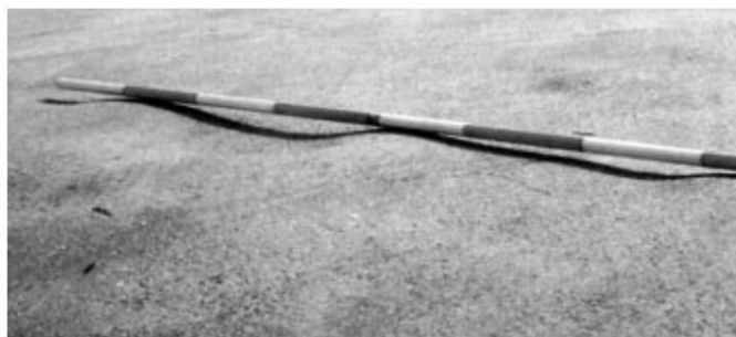
43-р зураг- Хүнд даацын ачааны машины үйлчлэлээр үүссэн хөндлөн долгион.
