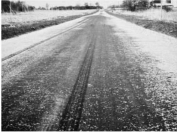
38-р зураг- Битумын хөөрөлт. Битум ихдэж гадаргуу дээр хөөрөн гарсан хэсэг нь харлан харагдаж байна.
