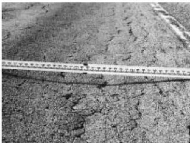
100-р зураг- Ашиглалтын 2 онооны түвшин. Дугйун мөрний хэсэгт ховил хагарал үүссэн, нөхөөс хийсэн хэсэгт дахин эвдэрсэн зам.
