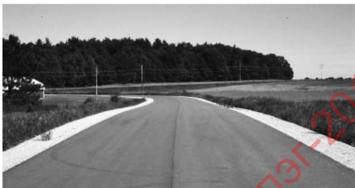
68-р зураг- Ашиглалтын 10 онооны түвшин. Шинээр барьсан зам.
