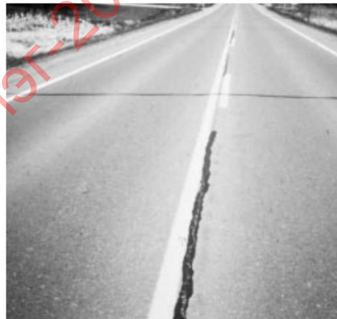
74-р зураг- Ашиглалтын 8 онооны түвшин. Хучилтын нийт хагарлыг бөглөсөн хучилт
