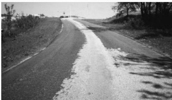
62-р зураг- Хучилтын ирмэгийг асфальтбетоноор манаж хүчитгэсэн байдал.
