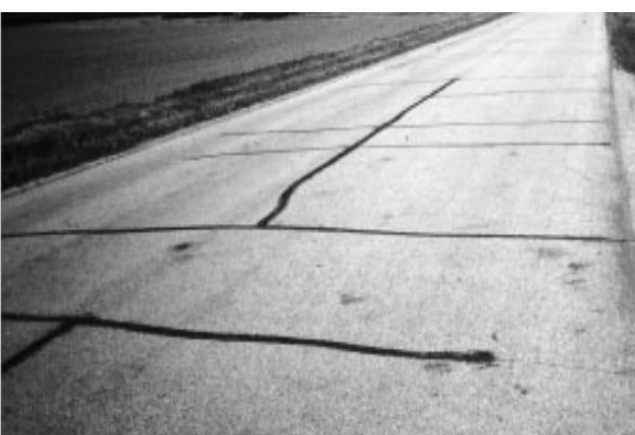
79-р зураг-Ашиглалтын 6 онооны түвшин. 3м-ээс хол зайтай хөндлөн хагарал үүссэн зам.
