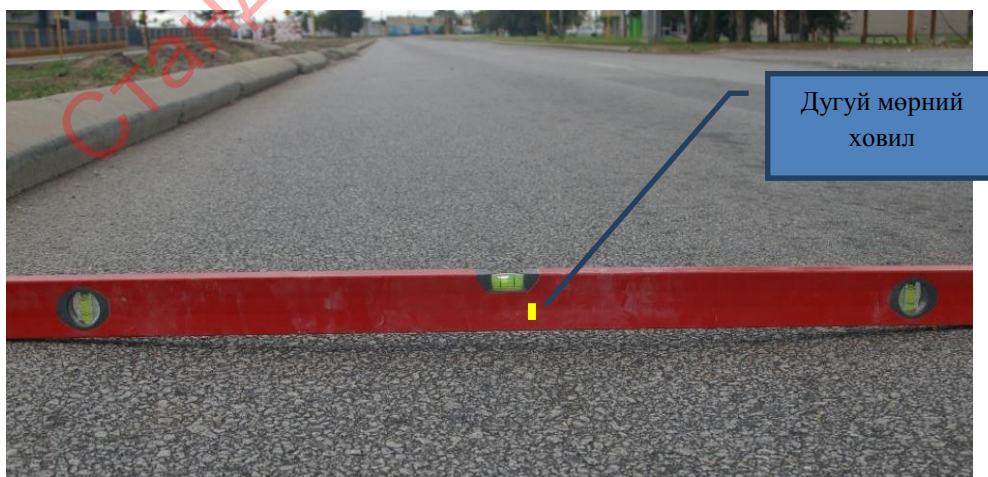
21-р зураг- Дугуйн мөрний хэсэгт чиглүүлэгч шугам байрлуулсан байдал
