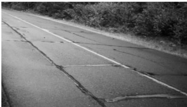
51-р зураг-Бетон хучилтан дээр дэвссэн битумэн overlay үенд бетон хавтангийн заадас орчимд үүссэн дамждаг хагарал.
